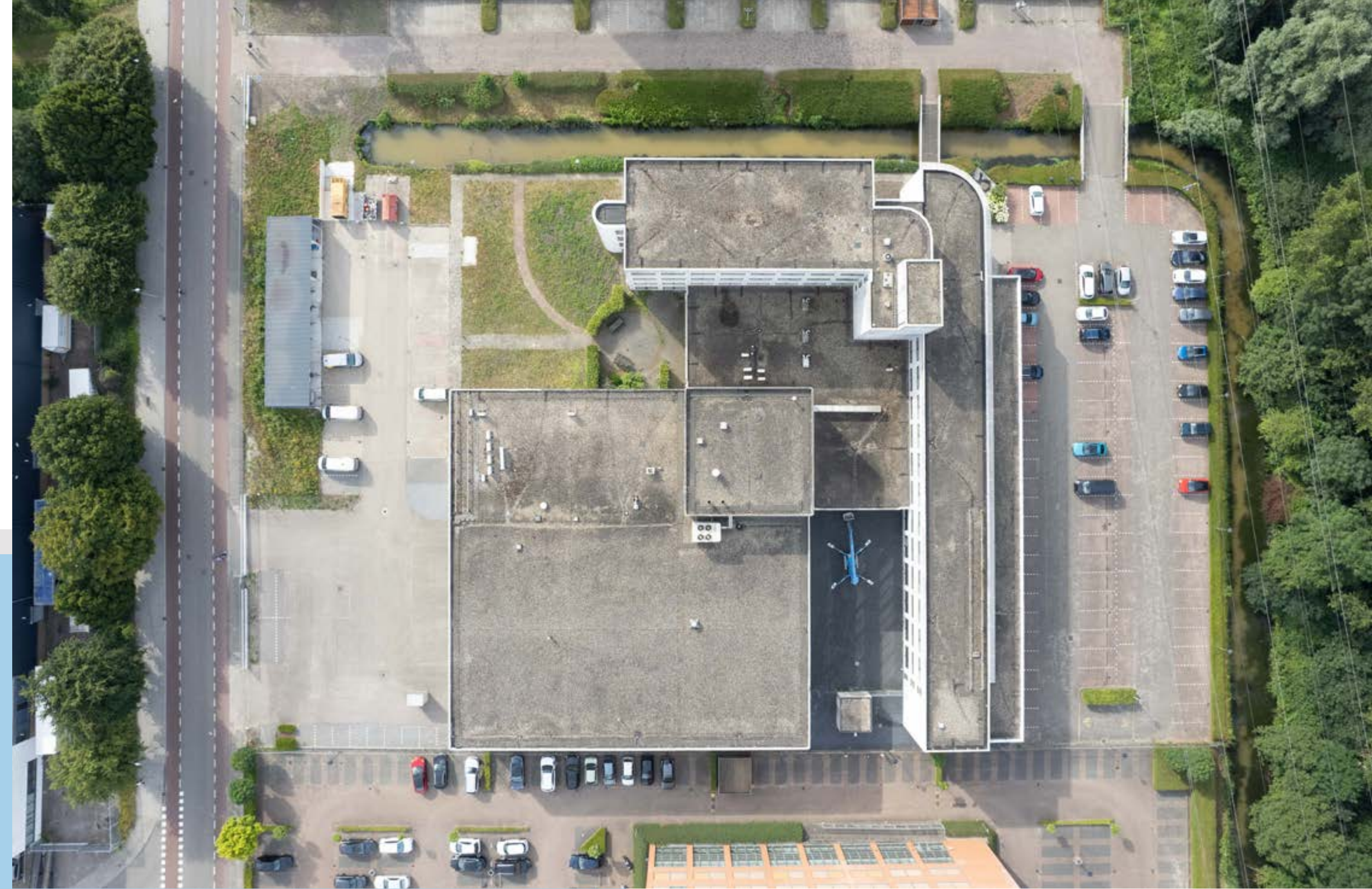
DE RUIJTE nieuwe situatie; 546 zonnepanelen en sedum dak voor de buitenruimte
